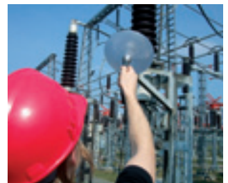
Verificarea izolației în exterior cu receptorul acustic parabolic.
