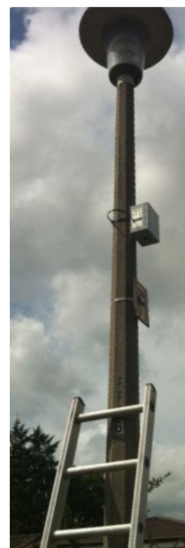
Instalații: repetor (stânga), GSM box (dreapta)
